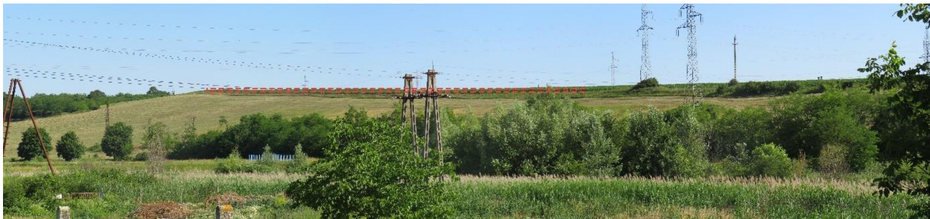
A 2. sz. módosítási terület a nógrádkövesdi Ady Endre utca végéből a szomszédos Nógrádkövesd 132/22 kV-os alállomás magasfeszültségű tornyaival. (Piros szaggatott terület a tervezett napelempark területe) (Forrás: saját felvétel)
