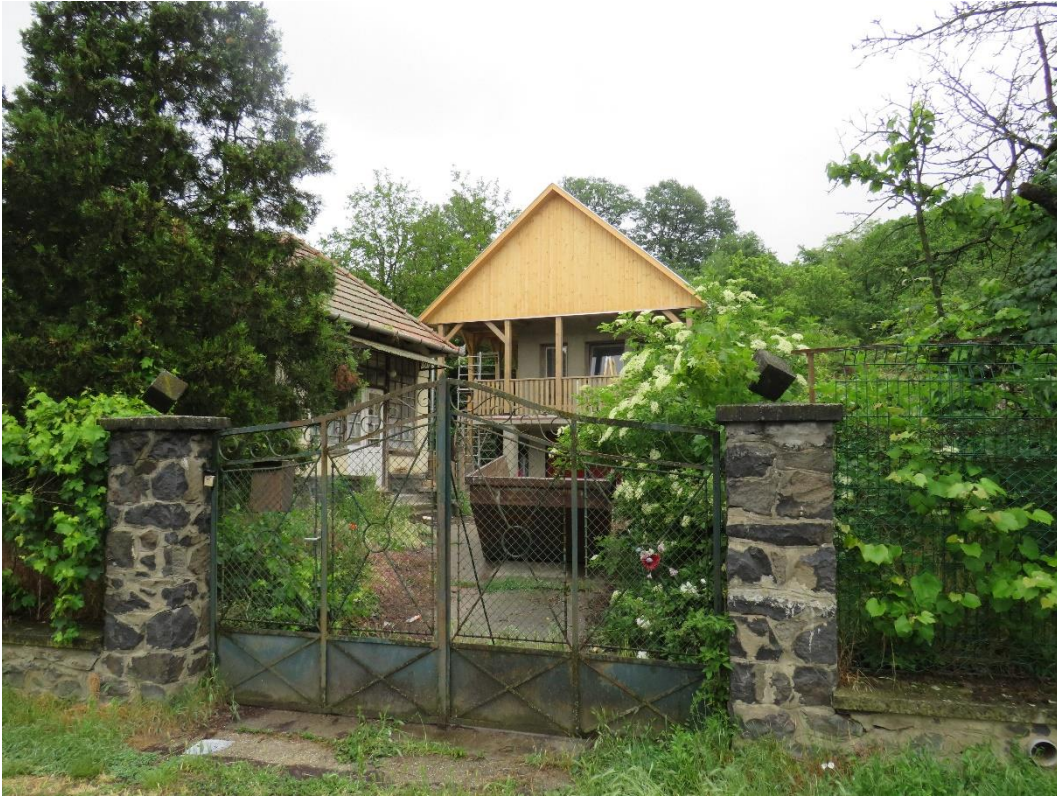
A 2. sz. módosítási területen meglévő családi házas beépítés(ek) az 519 hrsz-ú telken
