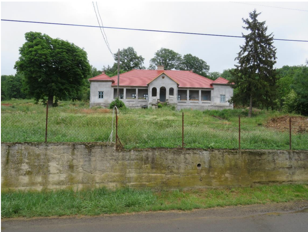
A 2. sz. módosítási terület szomszédságában található 518/3 hrsz-ú telek a Mühlád-kúriával
